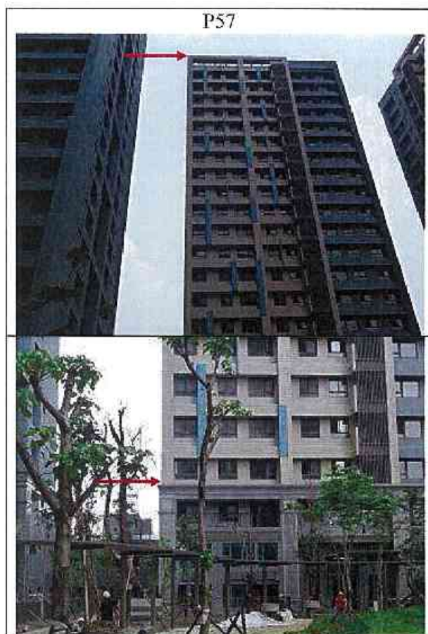
鑑定標的物牆柱角傾斜觀測位置及相片編號成果示意圖
