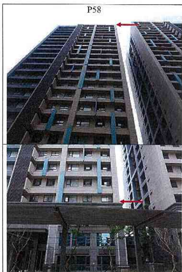
鑑定標的物牆柱角傾斜觀測位置及相片編號成果示意圖
