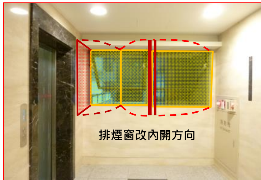
排煙窗修改內開方向
