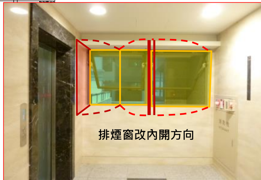
排煙窗修改內開方向
